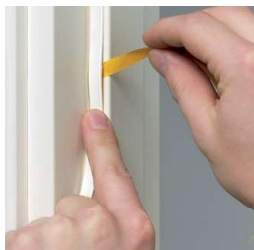
Montering af tætningsliste
